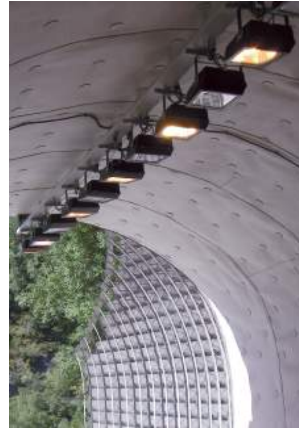
Infraestructura viaria: túnel
