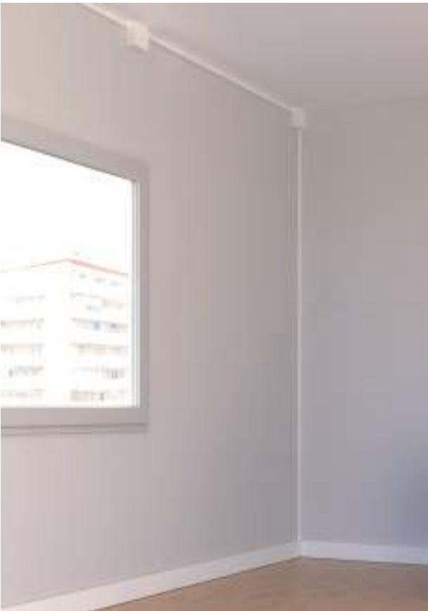
Rehabilitación de viviendas
