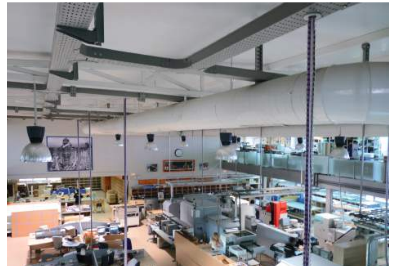
Nave industrial: oficina
