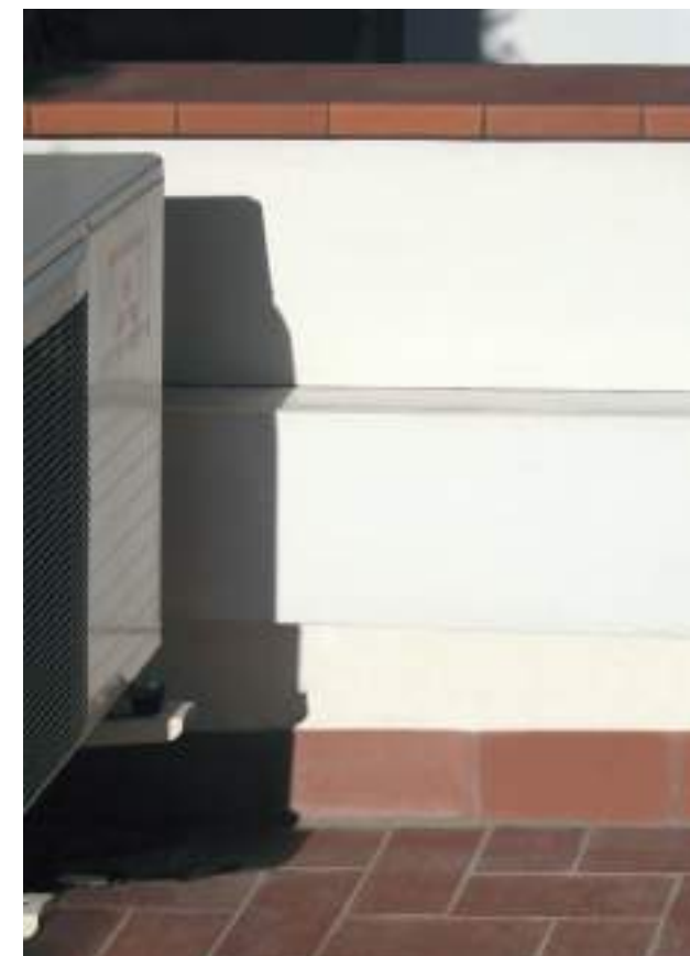
Rehabilitación de viviendas
