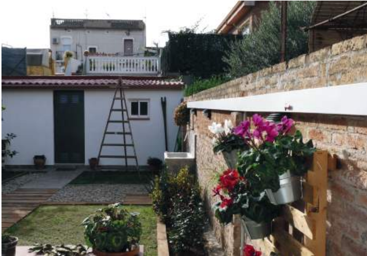
Rehabilitación de viviendas
