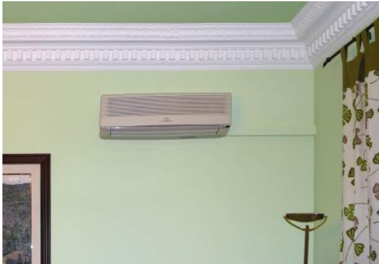
Rehabilitación de viviendas
